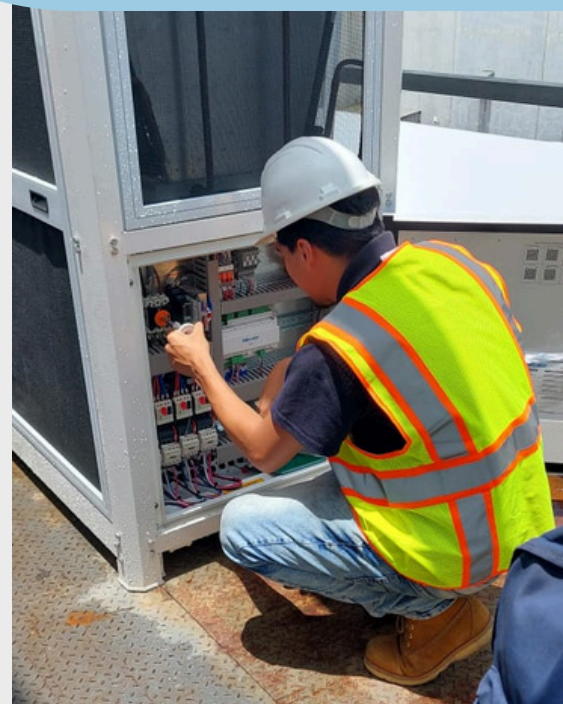
Servicio en un chiller Mecalor
